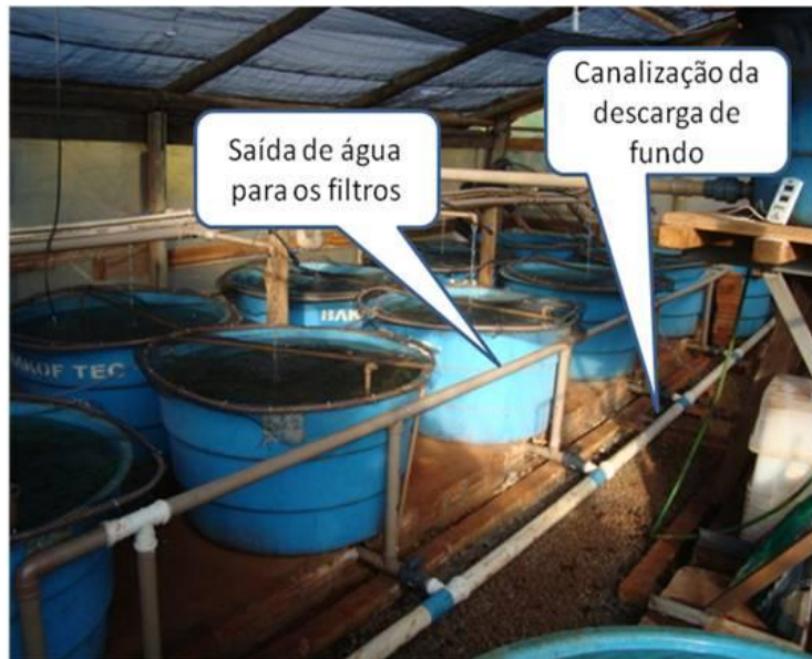
Figura 2. Sistema de criação de peixes com recirculação montado sob a estufa.
